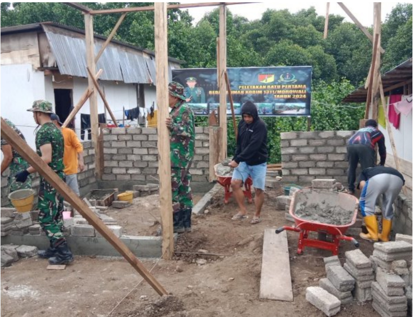
Tampak pengerjaan bedah rumah tahap pemasangan Batako
